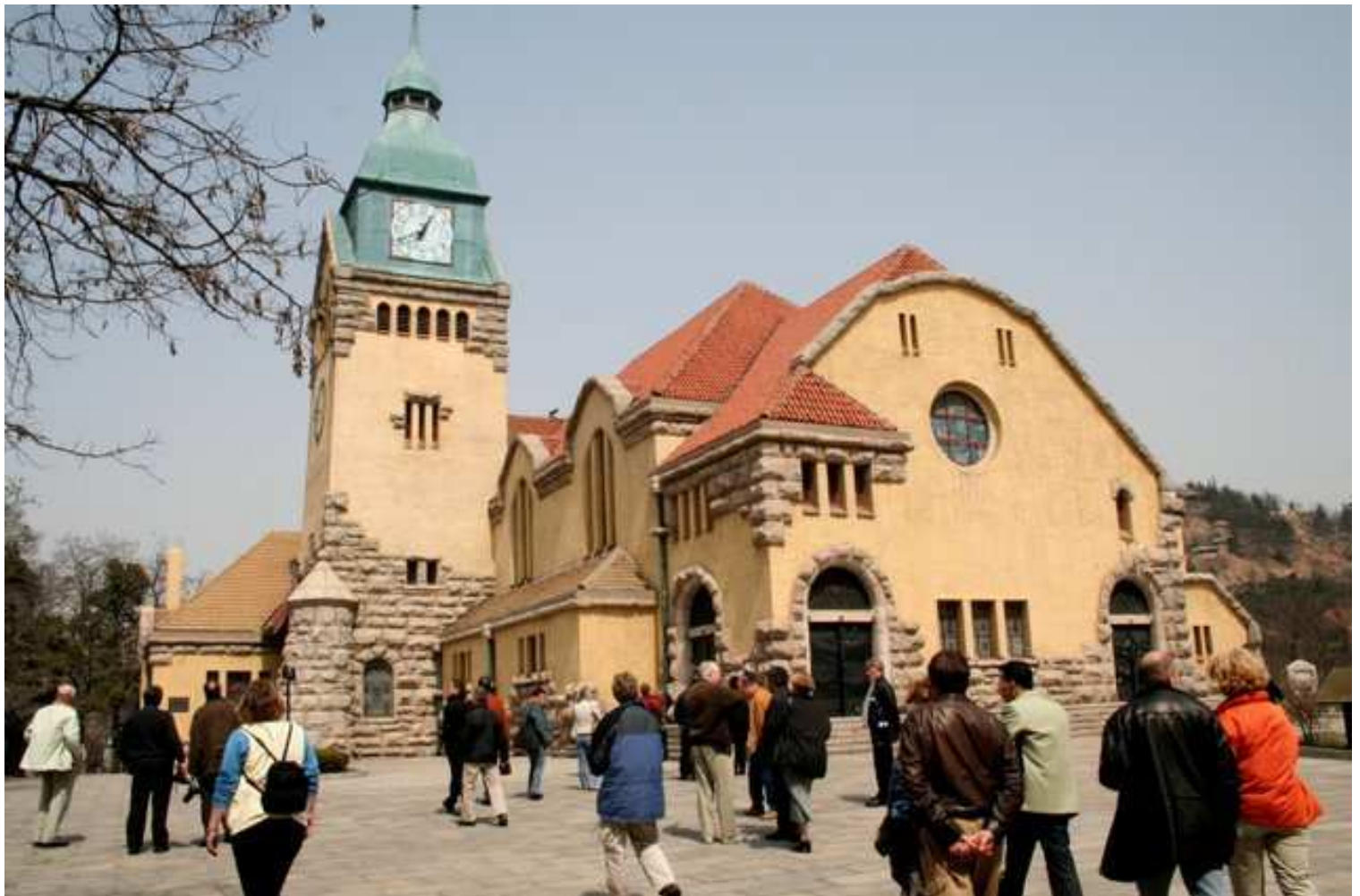
Die evangelische Kirche wurde 1910 fertig gestellt und hat 100 Jahre später ein neues Turmdach erhalten.
