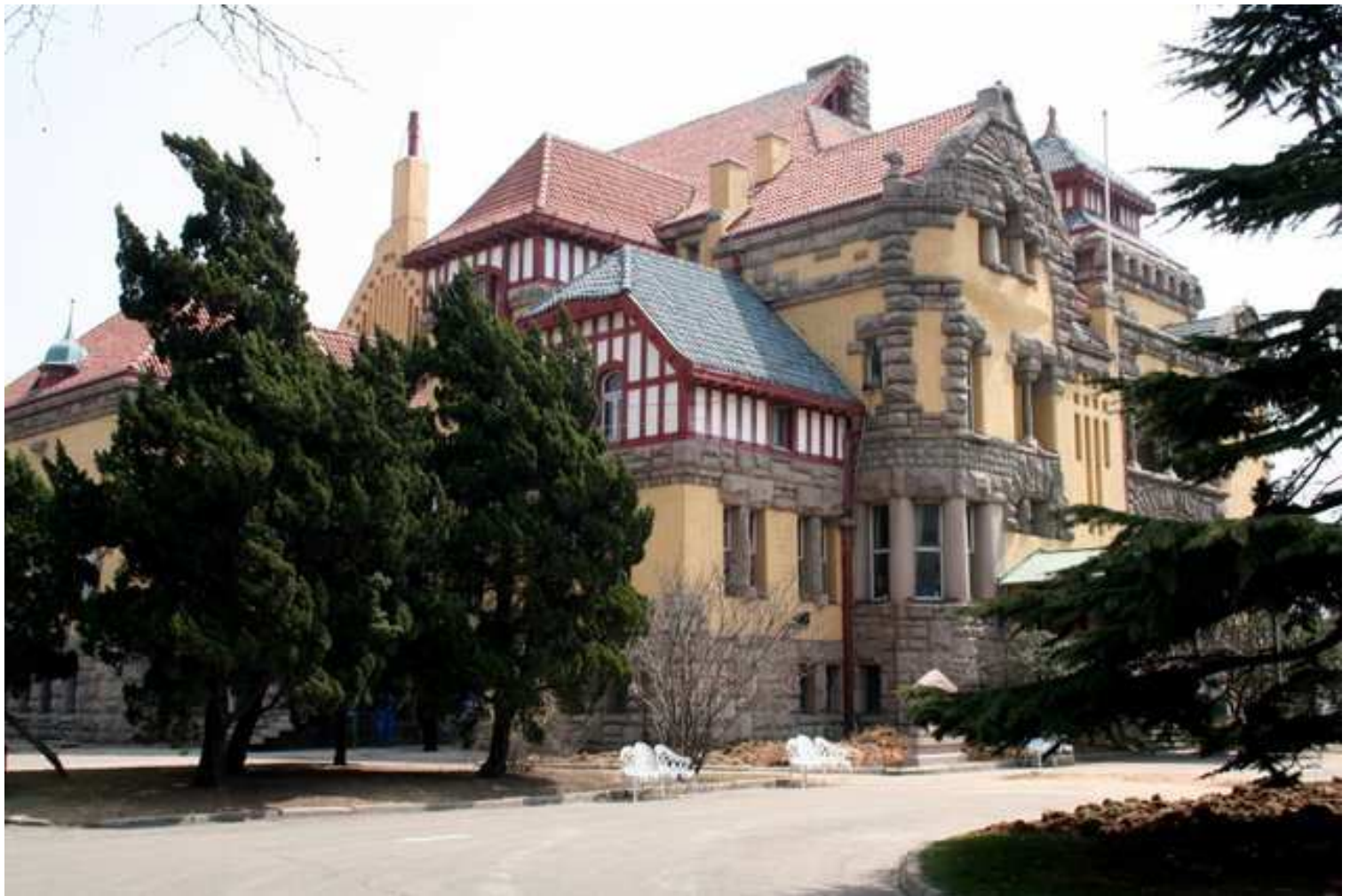
Das Gouverneurs Gebäude, das Regierungssitz des „Statthalters“ war, wird ein neues Dach erhalten.
